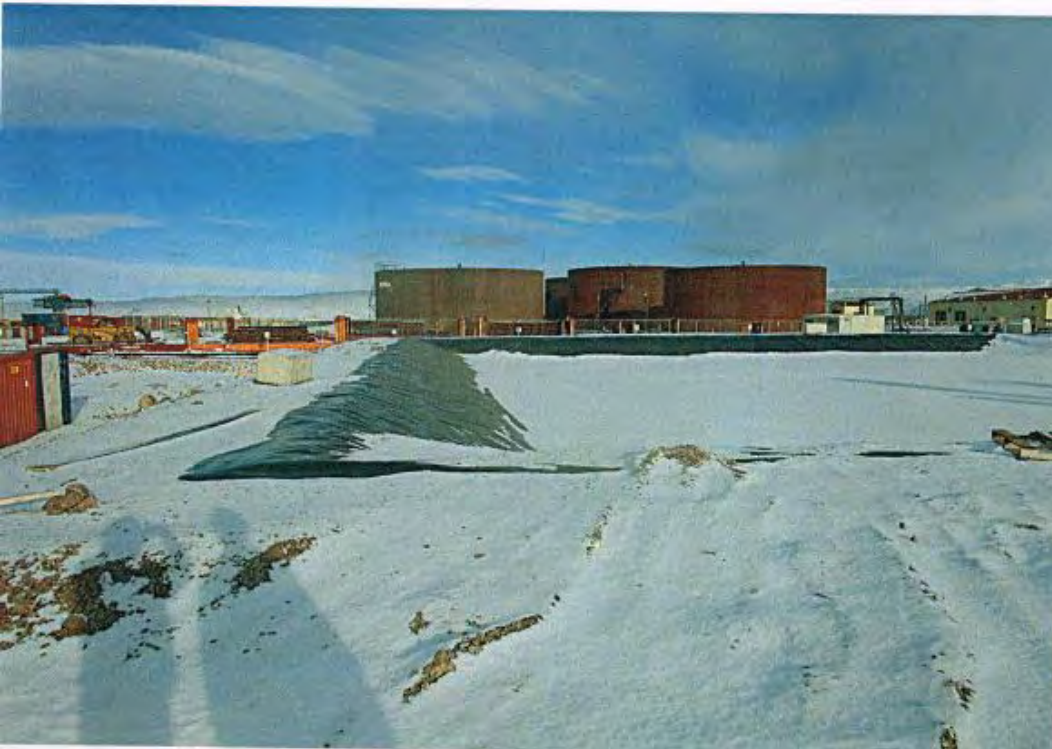
24. Milne Inlet Sewage Effluent Pond (PWSP)
