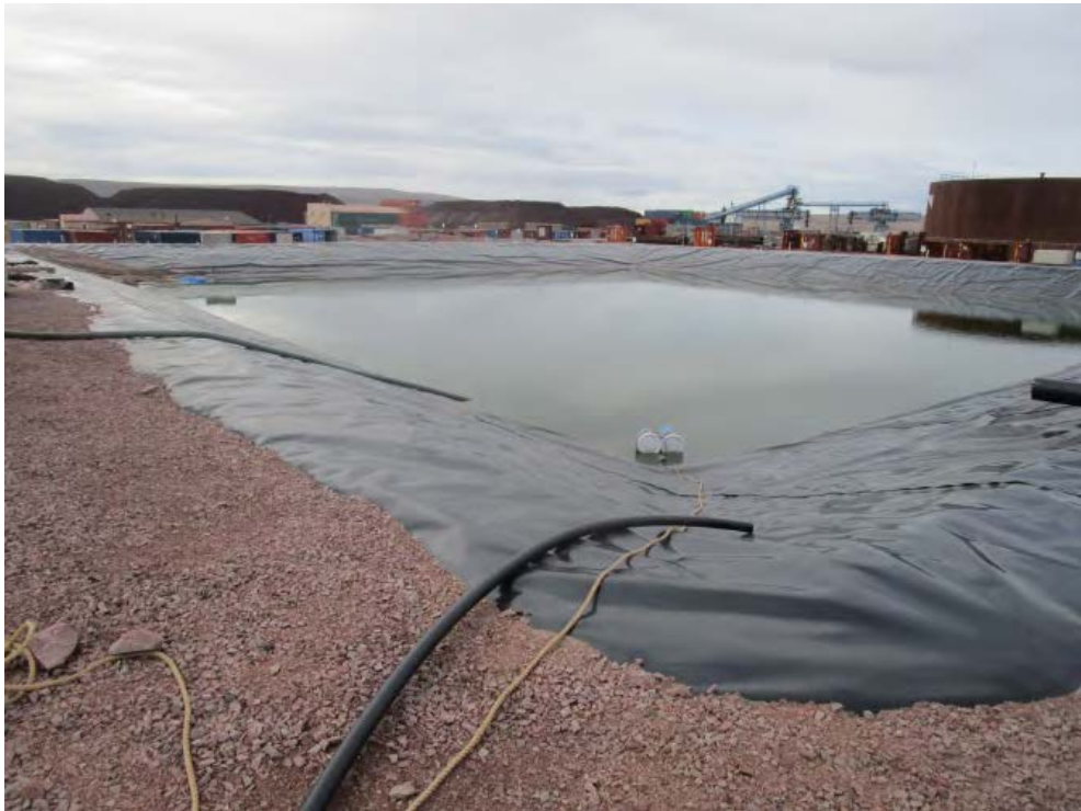
24. Sewage Effluent Pond (PWSP)
